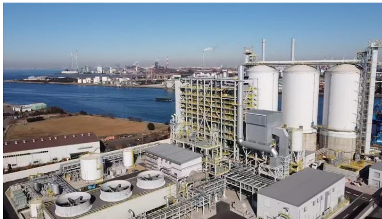
発電所の全景
