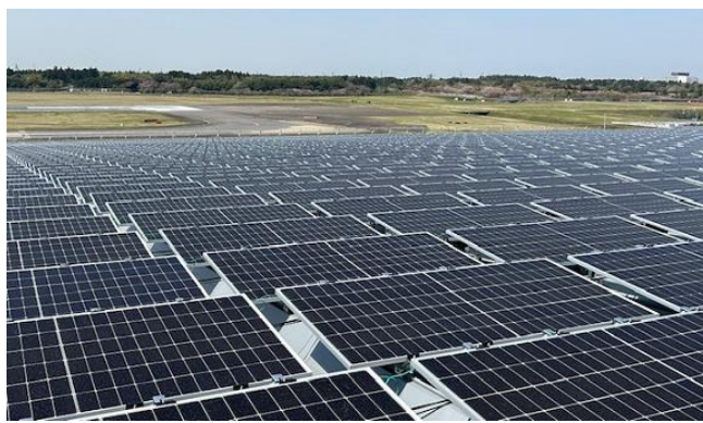
太陽光パネル設置状況
