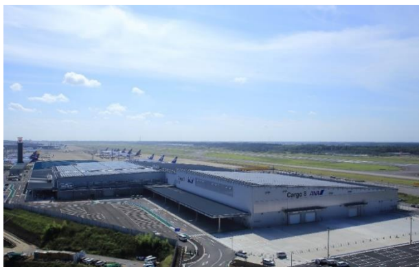
成田国際空港 第8貨物ビル
